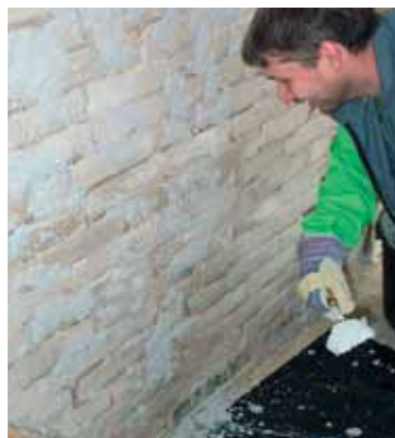
Spritzbewurfauftrag von KÖSTER Sanierputz weiß „schnell“.
