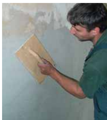
... und nach ausreichendem Anziehen abgerieben und geglättet.
